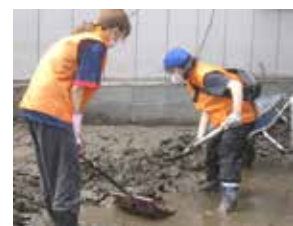
久慈市街地での泥上げ作業 (9月3日)
