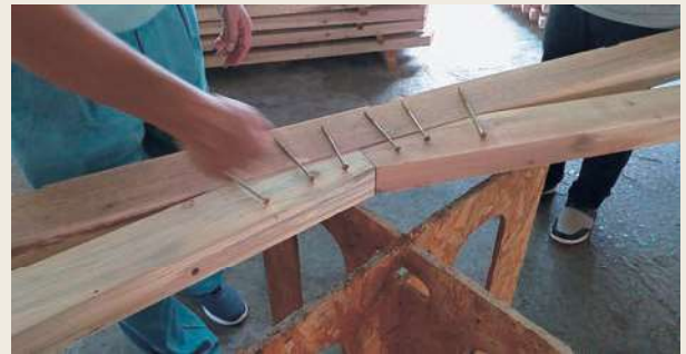
結合部分の現地調査の様子
