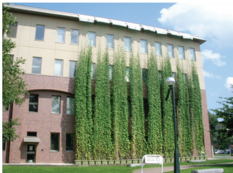
図書館西側壁面にアサガオを設置
