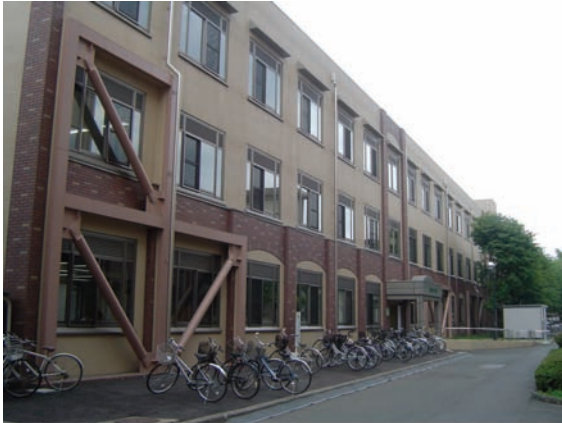
耐震補強(人文社会科学部3号館)
