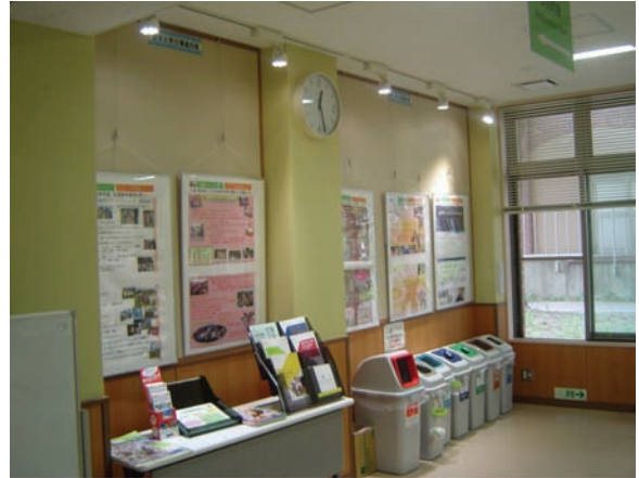
省エネ型のLED照明に改修
